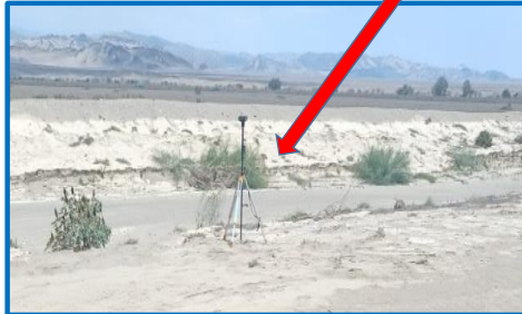
Conformación de dique con material propio
